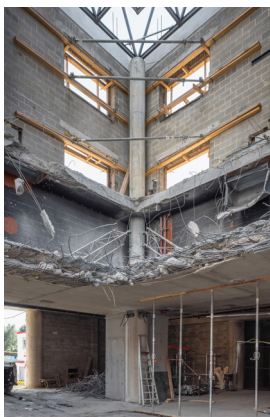
⑧ Le gabarit du théâtre est conservé, y compris au niveau de son iconique couverture en treillis [© C. Haubruge].
