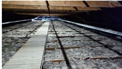
9 Réfection de la toiture.
