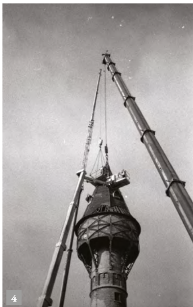
4 Démontage du chateau d'eau à Saint Luc Froyennes. (photo : Timothée Lunel-photoclub LOCITRN)
