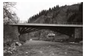
Pont Peiden Bad, Jürg Conzett.
