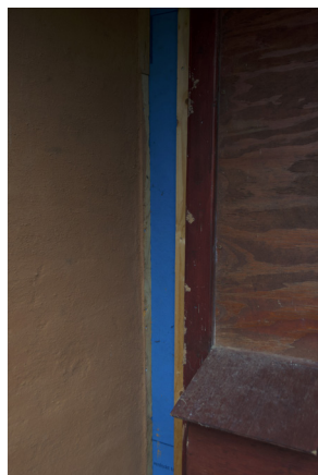
⑭ Jonction bois et terre-paille, en cours de finalisation (détail), années 2020.
