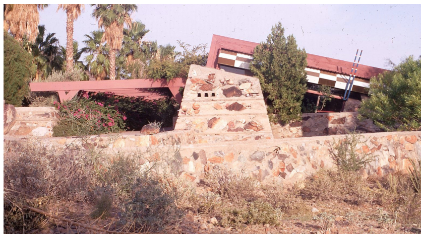
⑥ Les massifs de maçonnerie et les portiques en bois, 1972.
