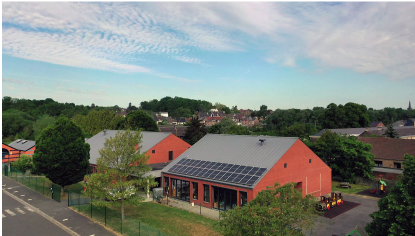
⑭ L'école La Gaminerie à Lessines. Panneaux photovoltaïques en toiture. Source : © Commune de Lessines
