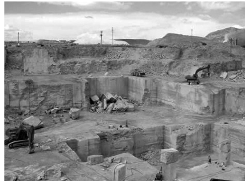
Le mur isolé et le trou
