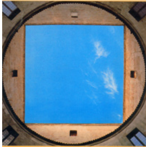
Casa del Mantegna : cour centrale
